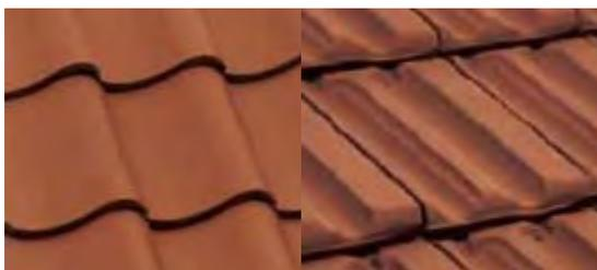
Abb. 89: Hohlziegel (links) und Doppelmuldenfalzziegel (rechts)
